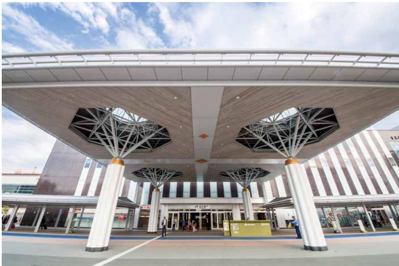
金沢駅西口シェルター
