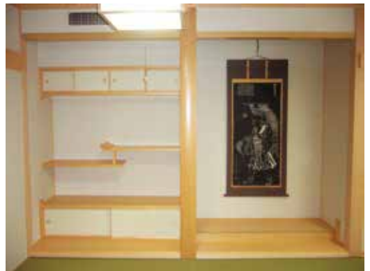
施工写真 桧貼甲丸柱
