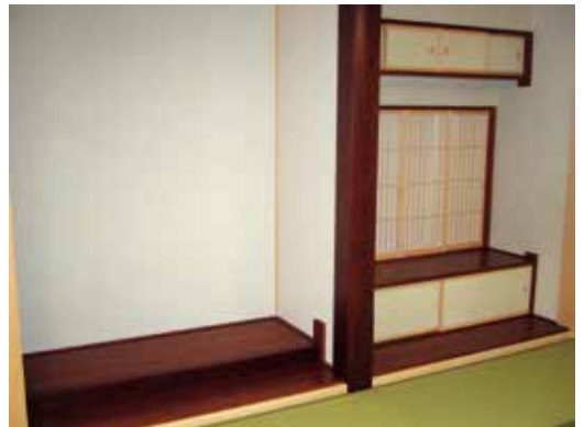
施工写真 花梨シート貼甲丸柱
