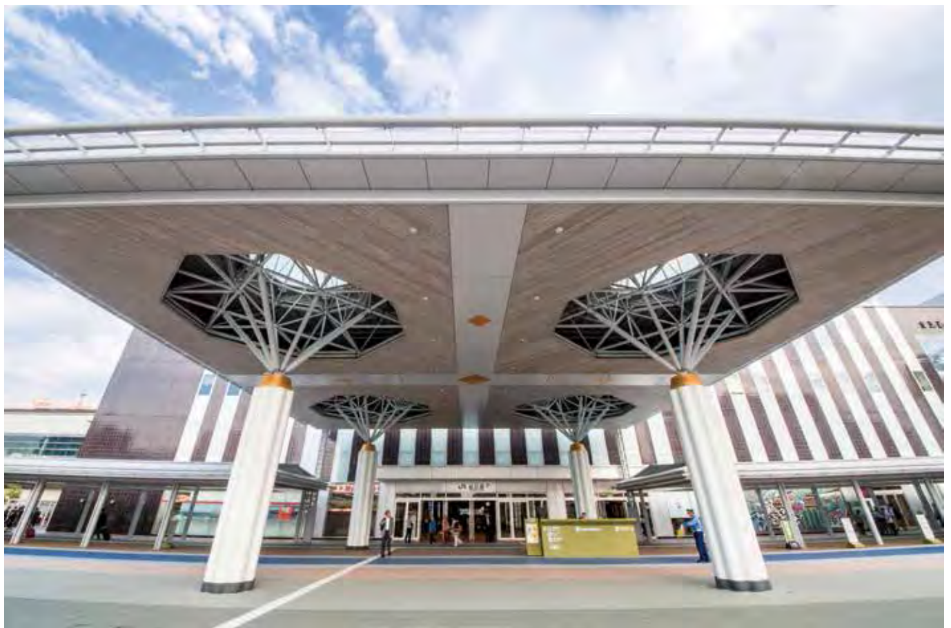
金沢駅西口シェルター
